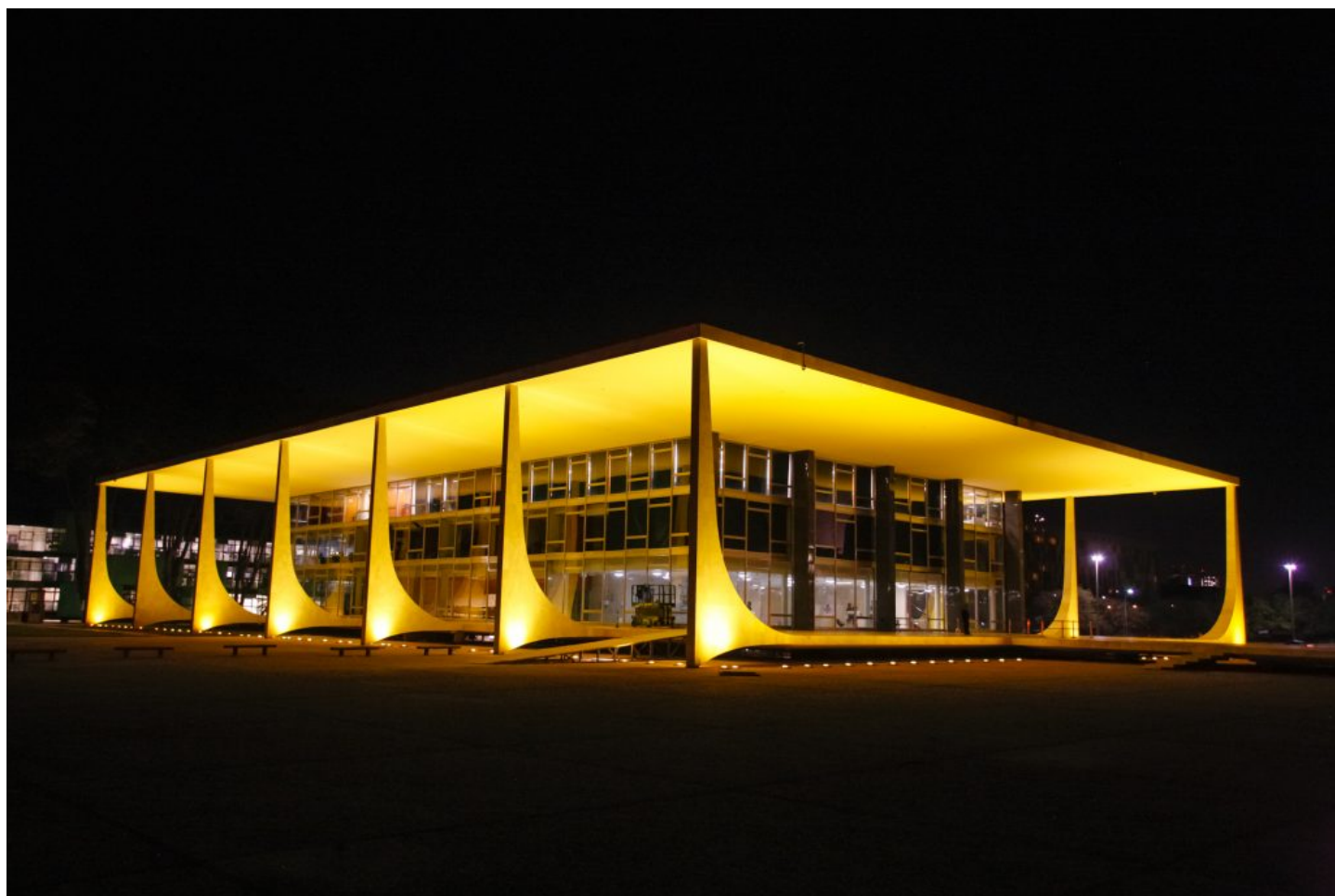
Prédio do STF. Foto: Fellipe Sampaio /SCO/STF
